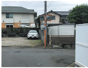
住吉町3丁目付近にカーブミラー 設置
