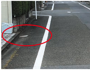
若松町2丁目付近の道路に水が溜まる とのご指摘を頂き、排水溝を改善
